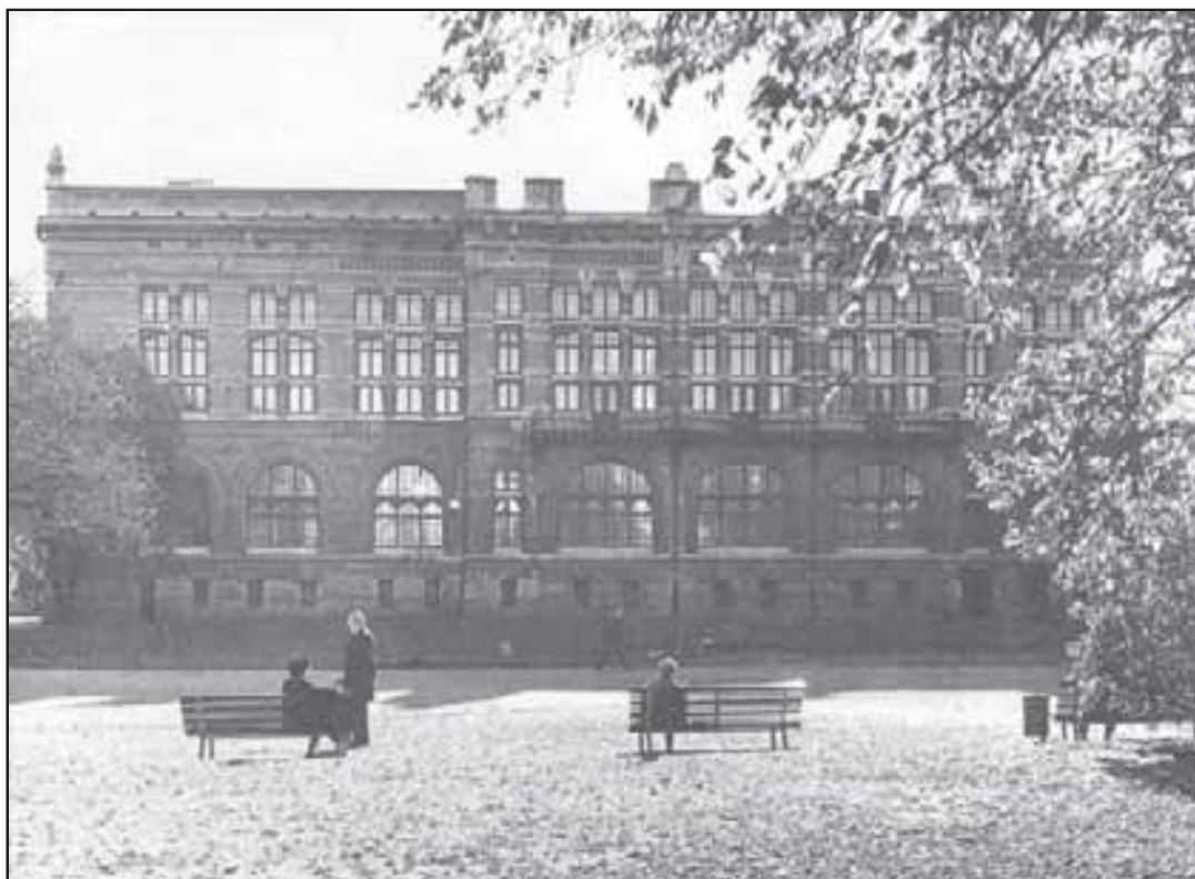
Bild 51. Göteborgs Stadsbibliotek var 1900-1967 inrymt i huset vid Haga Kyrkplan med entré från Vasagatan. Hans Hedlund formgav byggnaden i en säregen anglosaxisk-oriental arkitektur. Starkt målerisk verkan har erhållits genom kalksten med olika ytstrukturer omväxlande med rött beklädnadstegel. Enbart svenskt material ingår i fasaderna.
