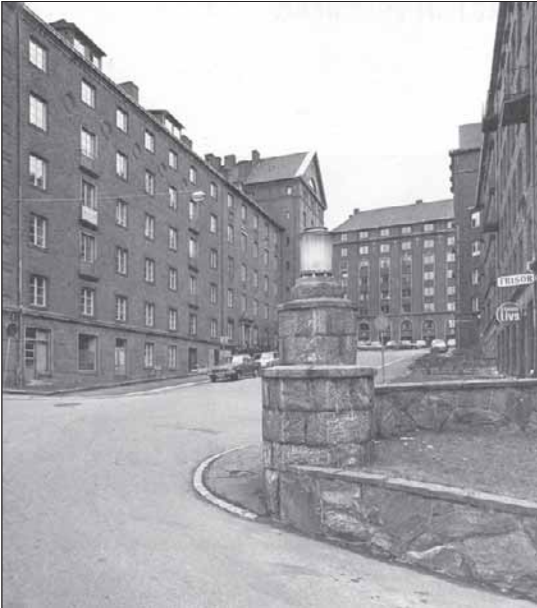
Bild 58. Terrassgatans gränsmurar, trappor och mörka tegelfasader (arkHJahnke mfl 1924-28) bildar stadsdelen Johannebergs klassicistiskt storstilade front mot den pittoreska villastaden och de monumentalt anlagda skolbyggnaderna nedanför, i den öppna och lummigt grönskande terräng som tidigare utgjort länderierna Götaberg och Lyckan. Denna naturanpassade stadsbyggnadskonst introducerades i Göteborg av stadsingenjör Albert Lilienberg.
