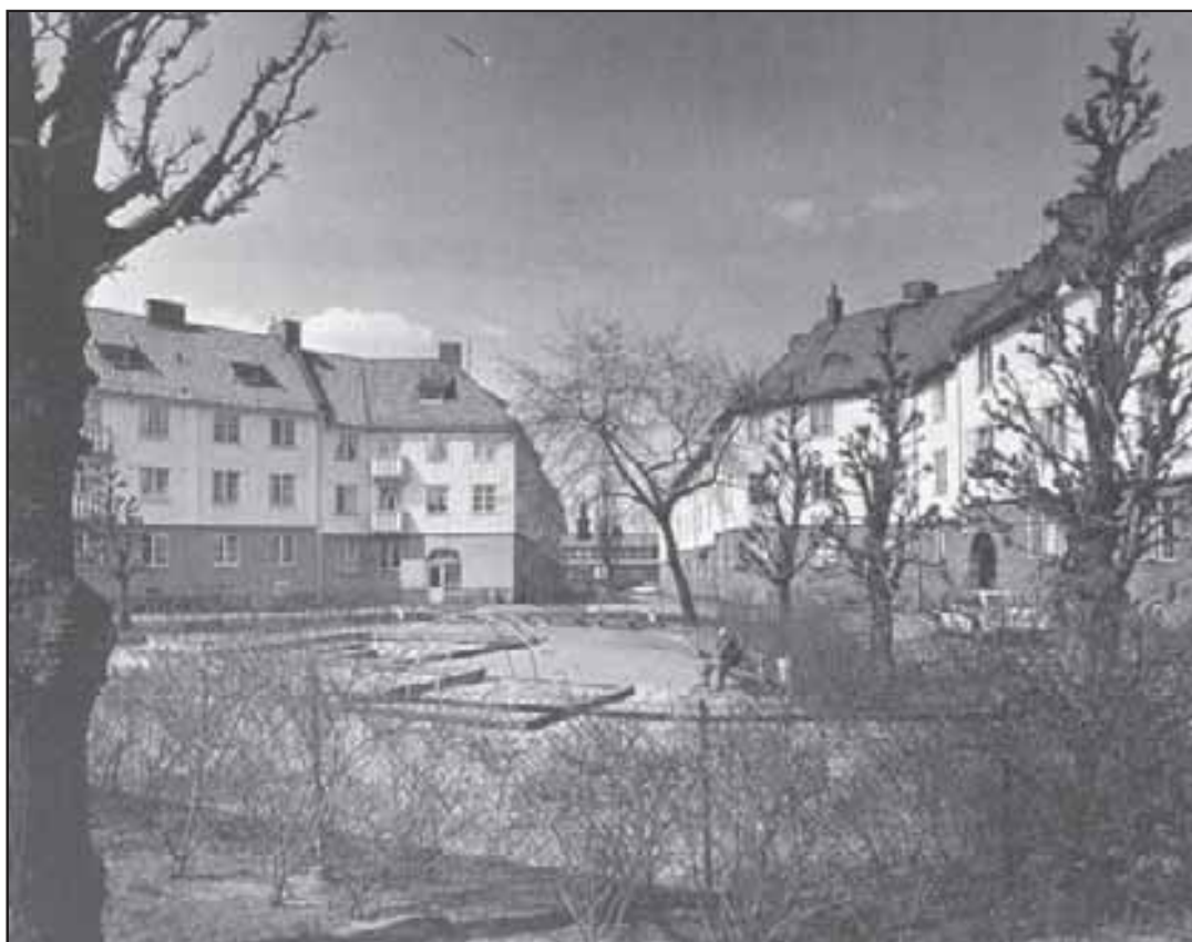
Bild 138. Landshövdingehuset på ömse sidor om Viloplatsen byggdes 1918-22 av Göteborgs stad för arbetare i dess tjänst. I fonden den egenartat gestaltade Bagaregårdsskolan (ark Johan Jarlén 1918) - ett mästarprov på den pittoreska monumentalitet som präglar nationalromantisk och 20-talsklassicistisk träarkitektur i Göteborg.
