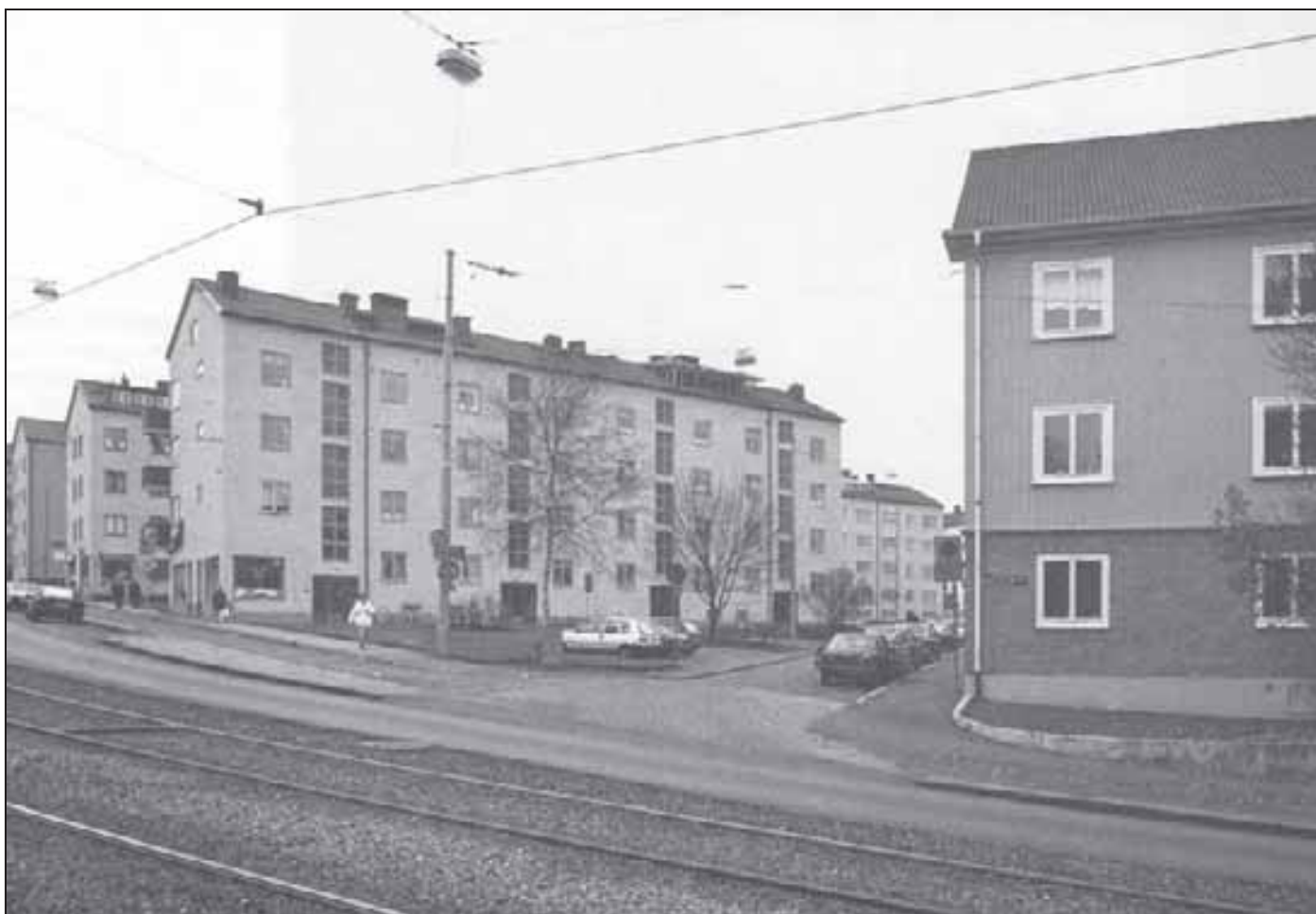
Bild 106. 1930-talets funktionalistiska byggnadstyper av enkelt utförande i Göteborg är representerade vid Fridhemsgatan mittför Västra Begravningsplatsen. Landshövdingehuset, här i lamellform, och det putsade stenhuset har båda kvardröjande drag av klassicistisk tradition.
